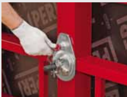
Пръстеновидният винт се затяга.
