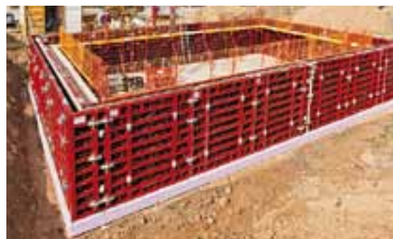
Кратко строителство - висока сигурност МАКСИМО и ПРОКИТ-странични предпазни мрежи към бетониращите конзоли Сутерен на еднофамилна къща, Вайсенхорн
