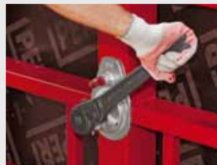
MX анкерът се затяга с анкерния ключ до ограничителя.
