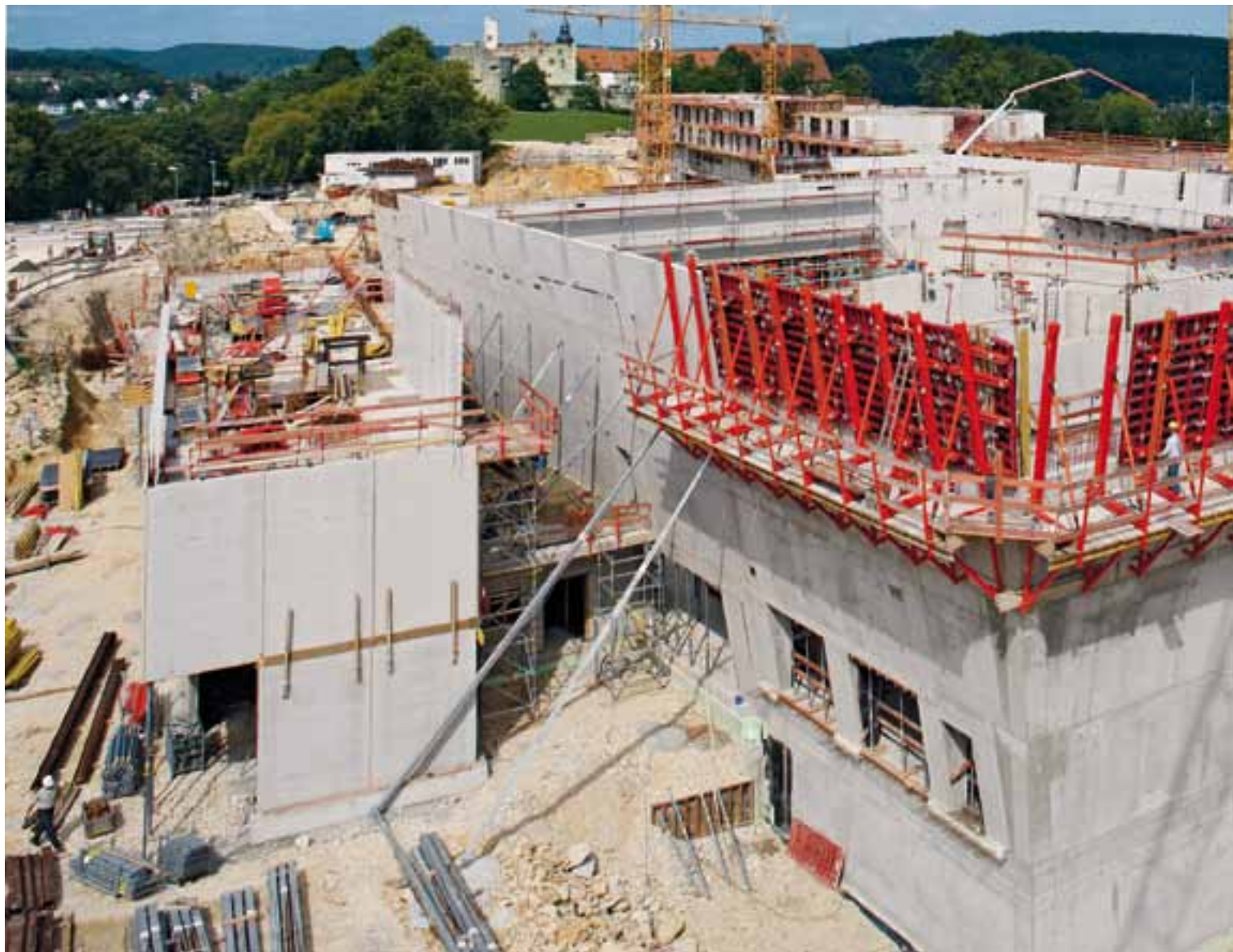
Кратко строителство - висока сигурност МАКСИМО и ПРОКИТ-странични предпазни мрежи към бетониращите конзоли Сутерен на еднофамилна къща, Вайсенхорн
