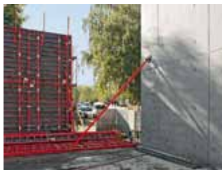
Регламентиран raster на фугите и анкерните отвори при оставащи видими стени Аутлет-център, Метцинген
