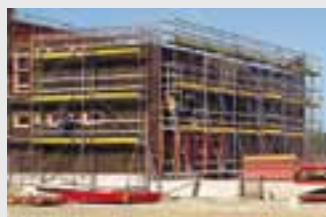
Строително работно скеле
