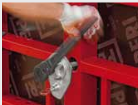
Анкерът MX се завива здраво с анкерния ключ докато се постави пръстеновидният винт.
