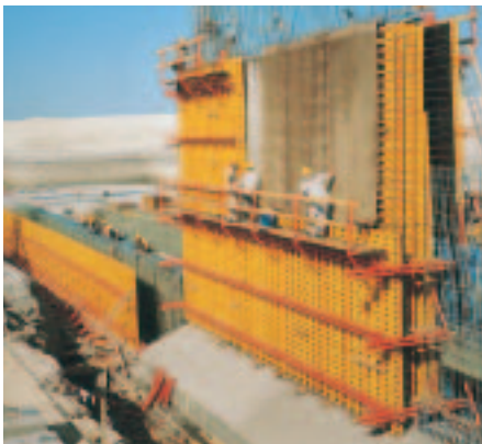
"ВАРИО GT 24" при строителство на пречиствателна станция с конусовидни стени
