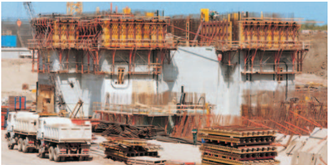
Окомплектована единица: "ВАРИО GT 24" на едностранно катерещо скеле SKSF 240.
