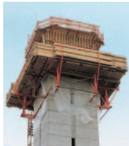
Църковна кула във Фелдмохинг при Мюнхен. "ВАРИО GT 24" на катерещо скеле KGF 240.
