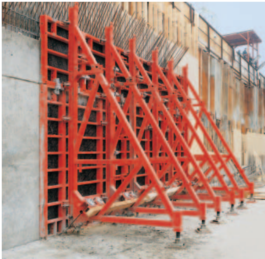
Опорна стойка SB-B и SB-C с рамков кофраж "ТРИО" Височина на бетониране 3,50 м.
