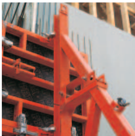
Опорната стойка С се монтира с два болта (спадат към доставката) върху стойка тип SB-A или SB-B.
