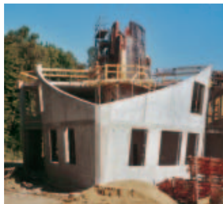
"РУНДФЛЕКС" при строителството на ресторант с формата на кораб. Тук проблемът се състои в константно променящия се радиус.
