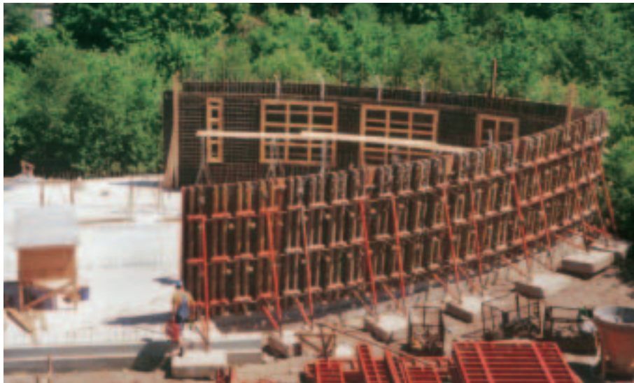
"РУНДФЛЕКС" при строителството на ресторант с формата на кораб. Тук проблемът се състои в константно променящия се радиус.
