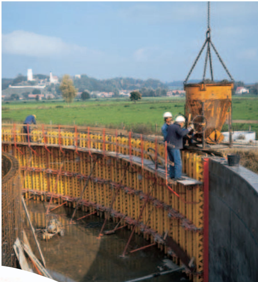
Кофраж "РУНДФЛЕКС" с височина 3,60 м за различни радиуси в строителството на пречиствателни съоръжения.
