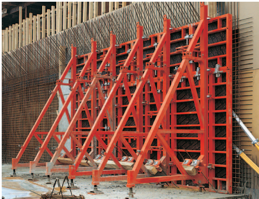
Опорна стойка SB-B и C с рамков кофраж "ТРИО" Височина на кофража 3,90 m.
