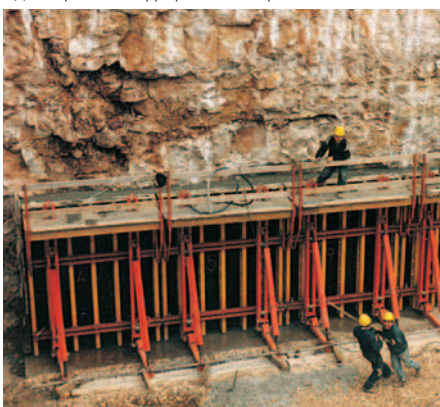
Еднострaнно кофриране с опорна стойка SKS.
