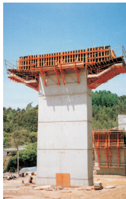
Опорна стойка SB-2 като носеща конструкция на кофраж на ригел на мостова колона.
